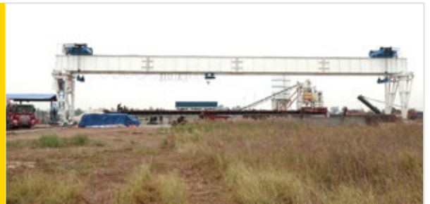
Cổng trục 100 tấn x Lk 48m, VIDIFI, Hải Phòng 100-ton x 48m gantry crane, VIDIFI, Hai Phong City
