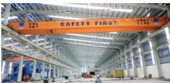
Cầu trục 30 tấn x Lk 30m, PV Pipe, Gò Công, Tiền Giang
