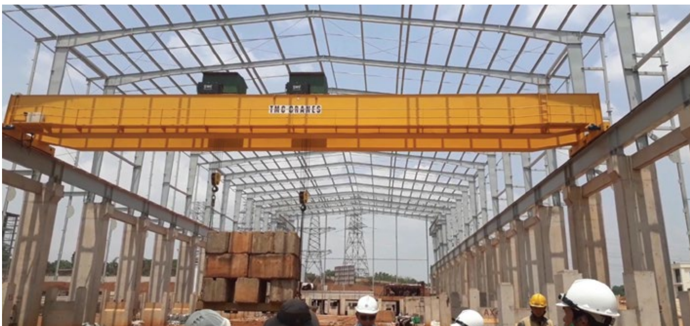
Cầu trục 50 tấn x Lk 27 m, Đắk Nông, Bình Phước 50-ton x 27m overhead crane, Dak Nong & Binh Phuoc Province
